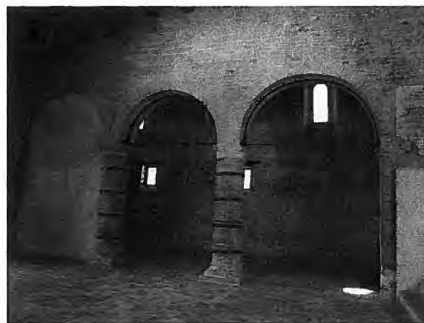
Abb. 29: Inneres, Laienkirche, Mittelschiff, linke Arkade mit Befund des Bogens von Bau II, Aufnahme H. Sahler 2010
