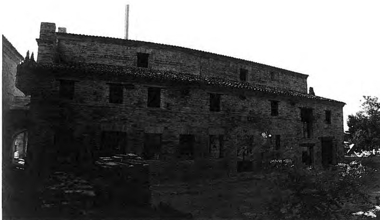
Abb. 7: Ansicht von Osten auf die rechte Außenwand, Aufnahme H. Sahler 2009
