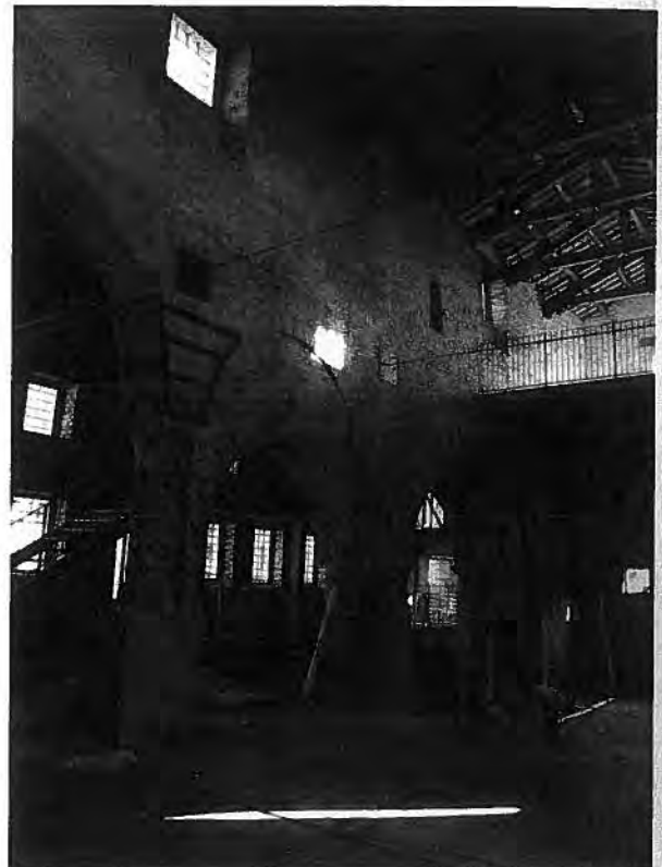
Abb. 25: Inneres, rechte Arkade mit Baufuge zwischen Presbyterium und Laienkirche, Aufnahme H. Sahler 2009
