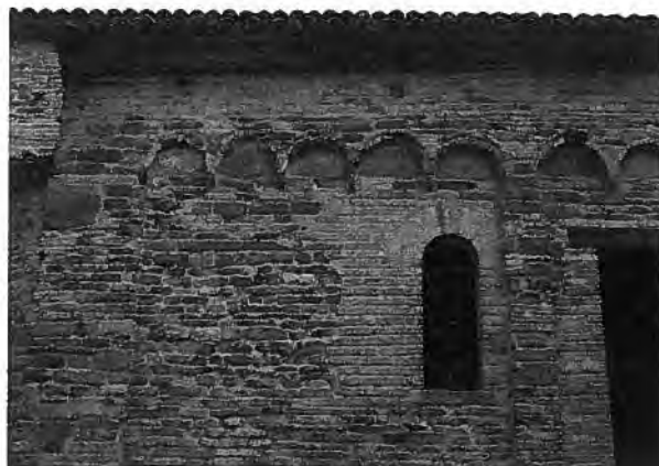
Abb. 21: linke Seitenschiffwand, nördlicher Teil, Rundbogenfries: Mauerwerk Typ 4, Aufnahme H. Sahler 2009
