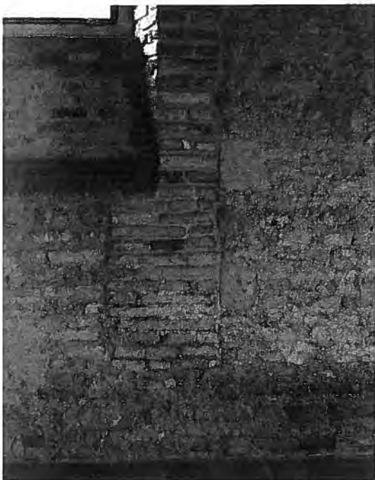
Abb. 28: Inneres, Laienkirche, Mittelschiff, rechter Obergaden, zugesetztes Fenster von Bau II, Aufnahme H. Sahler 2009
