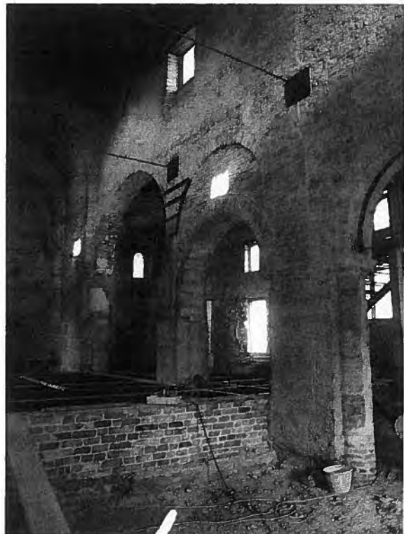
Abb. 13: Inneres, Presbyterium, rechte Arkade mit Baunaht am Übergang zur Laienkirche, Aufnahme H. Sahler 2009
