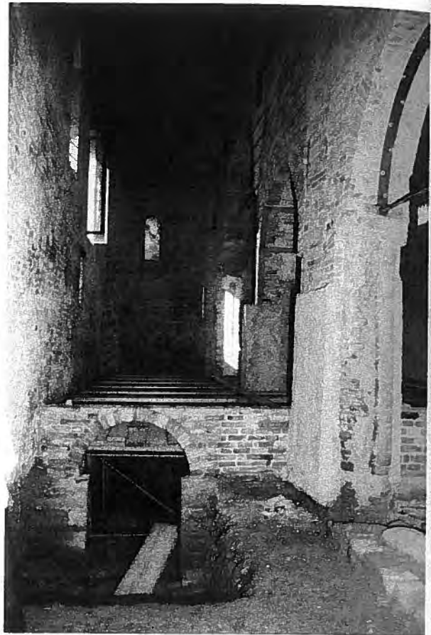
Abb. 31: Inneres, linkes Seitenschiff nach Norden, Baunaht zwischen Laienkirche und Presbyterium mit Befund des Mauerstücks vor der Kryptensüdwand, Aufnahme H. Sahler 2009
