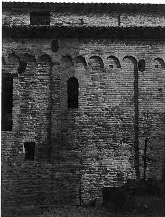
Abb. 24: linke Seitenschiffassade, mittlerer Teil mit Baufuge zwischen Laienkirche und Presbyterium, Aufnahme H. Sahler 2009
