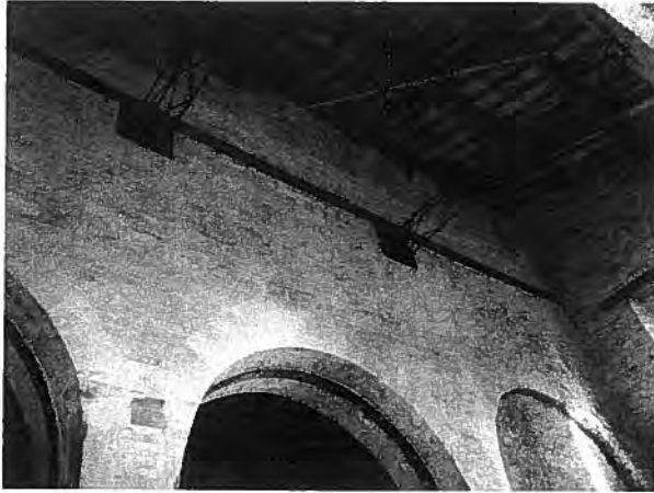
Abb. 30: Inneres, Laienkirche, linkes Seitenschiff, Arkade mit Befund des Bogens von Bau II, Aufnahme H. Sahler 2009
