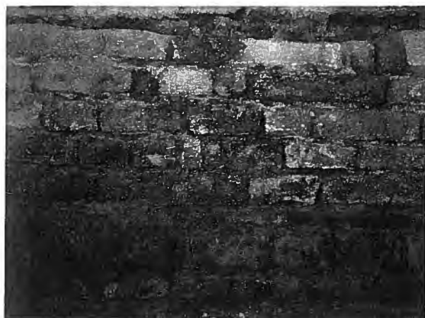
Abb. 20: Inneres, Krypta: Mauerwerk Typ 3, Aufnahme H. Sahler 2010
