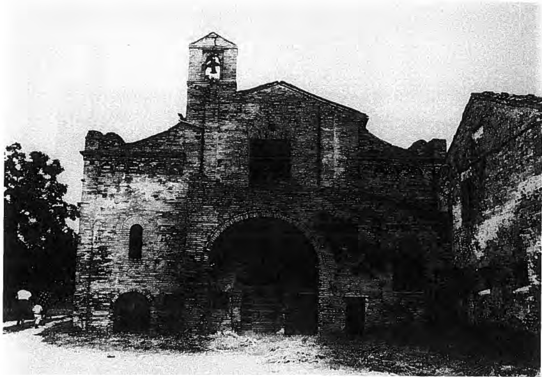
Abb. 8: Südfassade vor der Restaurierung, Aufnahme H. Sahler 1989
