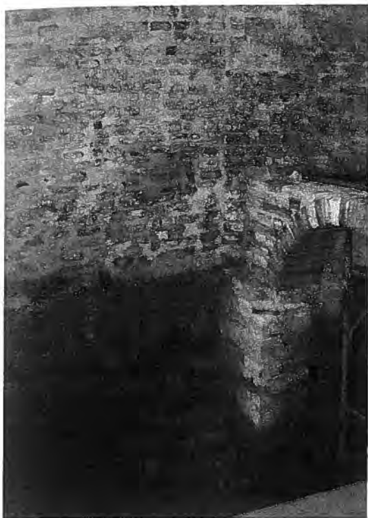
Abb. 18: Inneres, Laienkirche, linke Seitenschiffwand, Baunaht zwischen Mauerwerk Typ 1 (links, mit Befund Mauerrest) und Typ 3 (rechts), Aufnahme H. Sahler 2009
