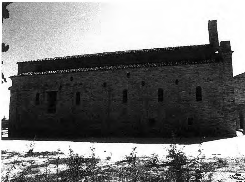
Abb. 6: Ansicht von Westen auf die linke Außenwand, Aufnahme H. Sahler 2010
